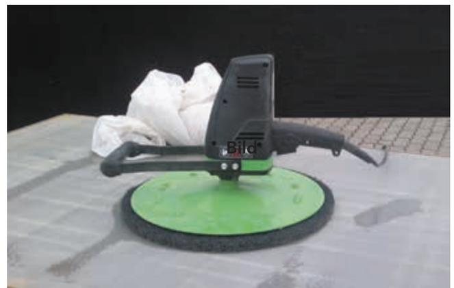
Schalhaut muss – zumindest wenn «Sichtbeton» gefordert ist – **mechanisch gereinigt** werden.
